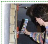
Montage von Innentüren
